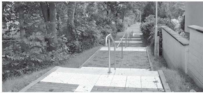
Die Treppe von der Wilhelm-Leuschner-Straße in Richtung Waldbach ist nun fertig gestellt - mit Kinderwagenrampe, taktilem Leitsystem und einem Rundgriffgeländer. Foto: mag
