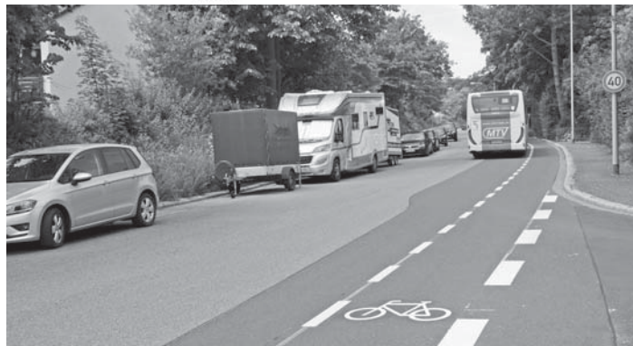
In den oberen Bereichen des Ost- und des Westrings wurden nun die Fahrradschutzstreifen des unteren Bereichs fortgeführt; aus Platzgründen aber nur auf einer Straßenseite. Foto: mag
