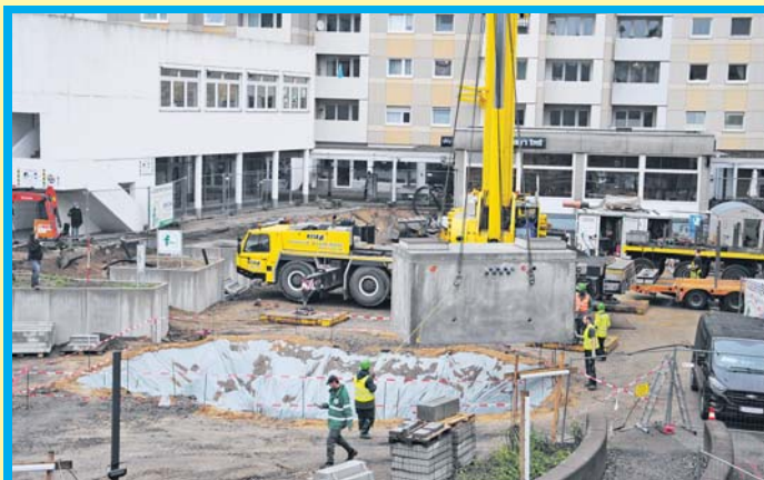
Bauarbeiten im Zeitplan. Am Dienstag vergangener Woche wurde am unteren Marktplatz die Brunnenkammer für das zukünftige Wasserspiel gesetzt. Ein Schwerlastkran hievte den 32 Tonnen schweren Betonkubus in die dafür vorgesehene Grube. Die Brunnenkammer enthält die Brunnentechnik für Pumpen, Steuerung und Filteranlagen sowie ein Wasserreservoir, darüber hinaus die Steuerung für die Bewässerung der Grünflächen. Für die kommende Woche ist der Beginn der Pflasterarbeiten geplant, zunächst im Eingangsbereich des Bürgerhauses sowie im Bereich der Rotunde, anschließend im Bereich der Treppen und Rampen zur Anbindung an den oberen Marktplatz. Die Bauarbeiten liegen nach Angaben der Stadtverwaltung im Zeitplan. Foto: mag
