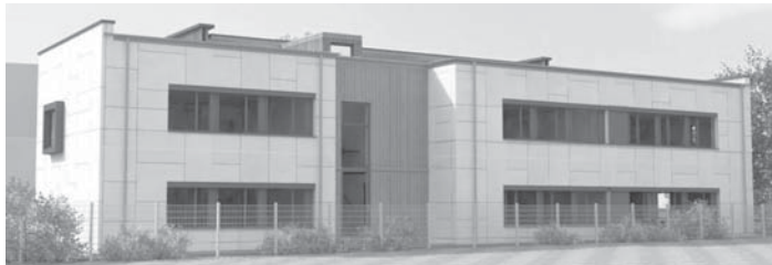
Fest einkalkulierte Gelder für einen AES-Erweiterungsbau werden vorerst nicht bewilligt. Grafik: MTK Auch der angekündigte Anbau an der Albert-Einstein-Schule ist vom KfW-Förderstopp betroffen
