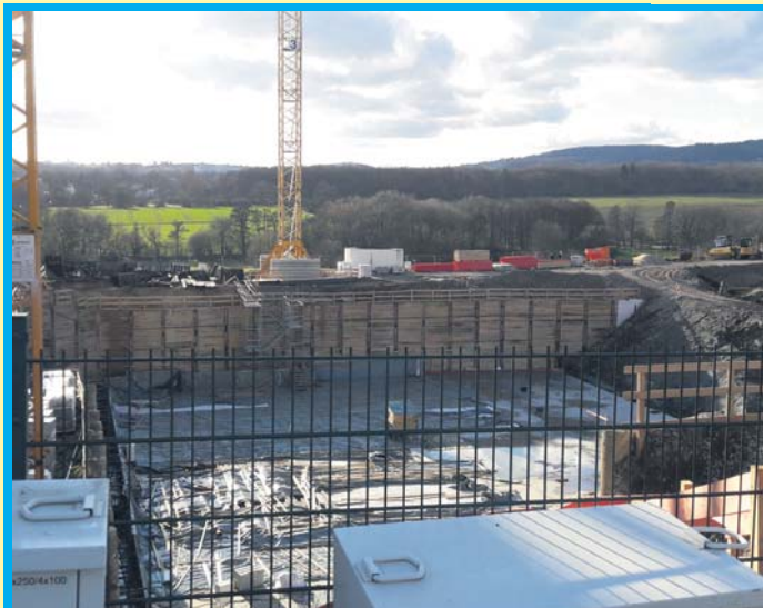
Riesige Baugrube. Ein gewaltiges Loch so groß wie ein Fußballfeld und etwa 10 bis 15 Meter tief klappt zurzeit am Ende der Straße „Am Kronberger Hang“. Auf rund 7.000 Quadratmetern Fläche entsteht dort ein Rechenzentrum der Firma „Maincubes“, das gleich mehrere Untergeschosse haben wird. Das Ries Loch wird allerdings schon in wenigen Wochen „zugebaut“ sein, denn das Rechenzentrum soll nach Angaben des Unternehmens bereits im Sommer 2023 in Betrieb gehen. Foto: Schlosser
