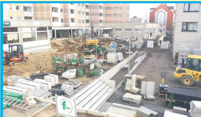
Der Schwerpunkt der Arbeiten wird in den nächsten Monaten auf den privaten Flächen unterhalb des „Bunten Riesen“ liegen. Ab März werden die neuen Bäume gepflanzt. Foto: Schlosser
