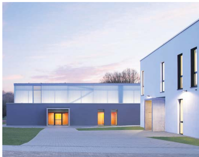
Die Neubauten von Sporthalle und Jugendhaus an der Heinrich-von-Kleist-Schule in Eschborn können am Samstag von 13 bis 16 Uhr im Rahmen des Tags der Architektur 2022 besichtigt werden. Insgesamt nehmen vier Projekte aus dem MTK teil. Foto: Heidenreich
