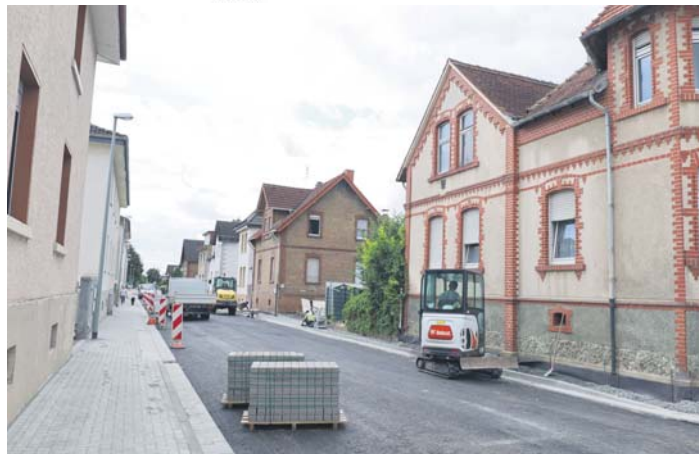
Der erste Teil des aktuellen Bauabschnitts zwischen den Straßen „Am Erlenborn“ und Schützenstraße ist fast fertig. Es fehlt nur noch die abschließende Asphaltdecke. Foto: mag
