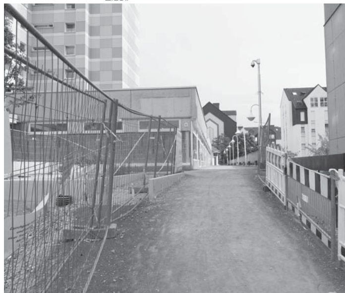
Die Fußgängerbrücke über die Avrilléstraße ist in den nächsten Wochen vom Marktplatz aus nur über eine provisorische Schotterrampe zu erreichen. Foto: mag
