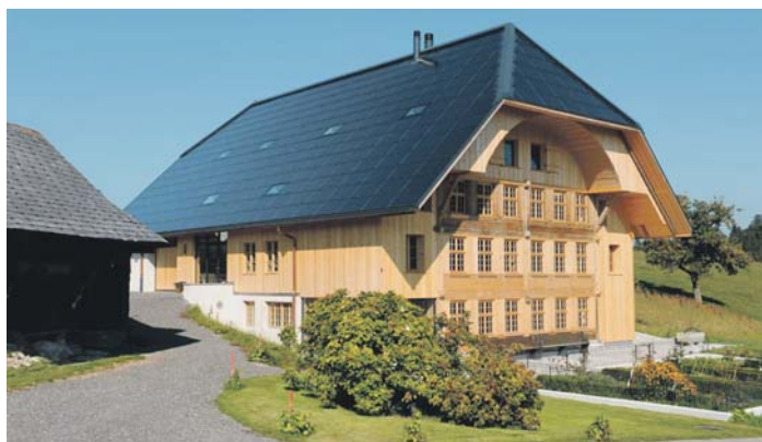
Bei Solardächern von „3 S“ werden die Module nicht auf das Dach montiert, sondern in die Gebäudehülle integriert. Außerdem kann die Farbe des Daches individuell angepasst werden. Foto: 3S
