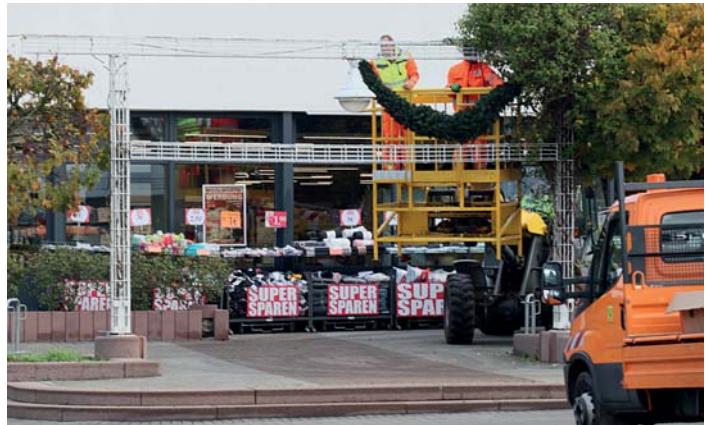
Es weihnachtet schon. Städtische Mitarbeiter haben in den vergangenen Tagen die Weihnachtsdekoration auf dem Schwalbacher Marktplatz aufgehängt. Beleuchtet werden dabei nur einige Straßen in Alt-Schwalbach und der Marktplatz – alles mit sparsamer LED-Technik, wie die Stadt versichert. Darüber hinaus soll die Weihnachtsbeleuchtung wie in den vergangenen Jahren um 22 Uhr ausgeschaltet werden.
