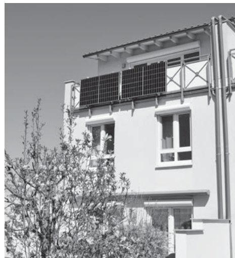
Einen Teil des eigenen Stroms kann man mit einem sogenannten „Balkonkraftwerk“ erzeugen, das nicht viel Platz braucht. Foto: privat
