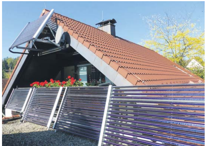
Die „Akotec“-Vollvakuumröhren lassen sich auch flach an der Fassade oder ans Balkongeländer montieren sowie auf ein Flachdach legen. epi/Foto: Akotec
