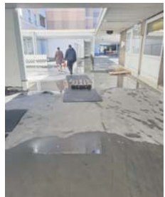
Die Baustelle am „Bunten Riesen“ stört viele. Foto: privat
