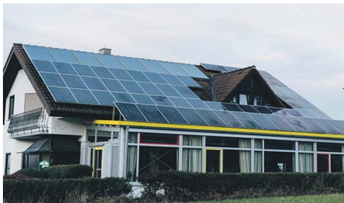
Eine große Photovoltaik-Anlage auf einem Einfamilienhaus produziert mehr Strom als seine Bewohner benötigen. In Vordertaunus sind die Bedingungen günstig. Foto: Winkler/Pixabay
