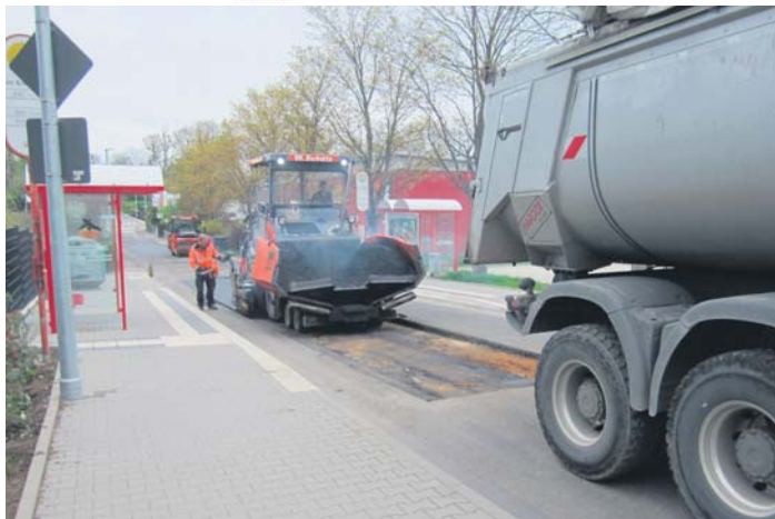
Die Straße „Am Erlenborn“ ist bereits seit dem vergangenen Mittwoch wieder befahrbar. Die Schlaglöcher und Asphaltaufrüche wurden durch den Einbau einer Asphalt-Tragdeckschicht beseitigt. Foto: mag
