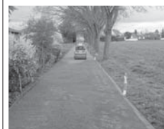
Der Fußweg zwischen der Eschborner Straße und dem Fasanenweg wurde in den vergangenen Wochen erneuert. Foto: mag
