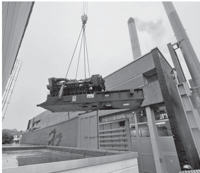
Ein Kran hob das alte Blockheizkraftwerk aus dem Fernheizwerk heraus.
